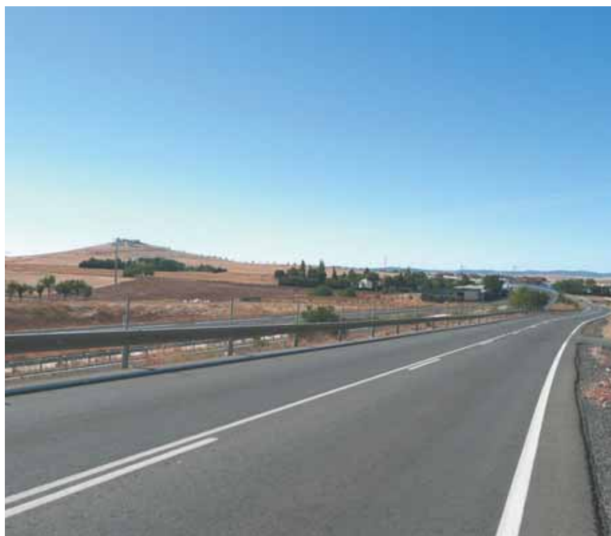
Figura: 3. Vista de la calzada, en sentido a Puertollano, con ajuste de trazado entre la localidad de Poblete, a la derecha, y el edificio volcánico sobre el que se levanta la ermita de San Isidro. La calzada se asienta sobre basaltos olivínicos negros muy alterados. A su salida, hacia el Sur, el trazado se ciñe al maar de Poblete.
