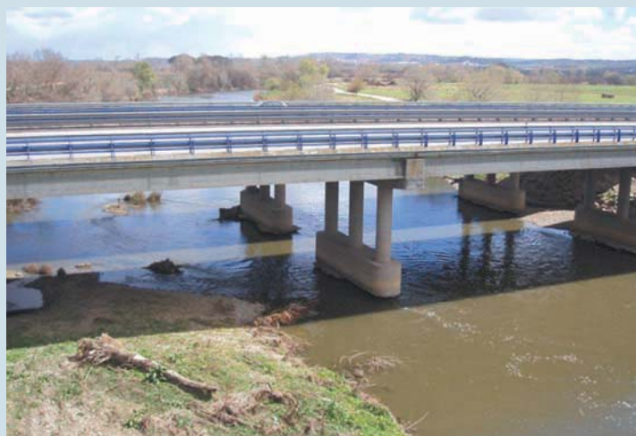
Obra de paso pilotada.
