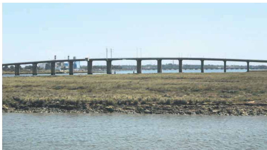
Figura 17. Puente sobre el Estero del Burro Grande.
