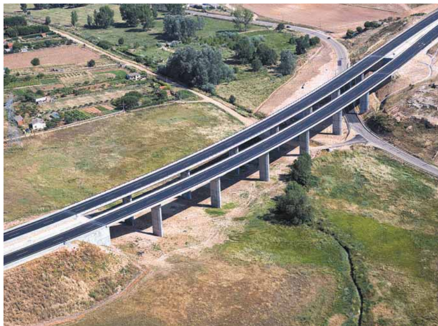
Viaducto (estructura E-7).
