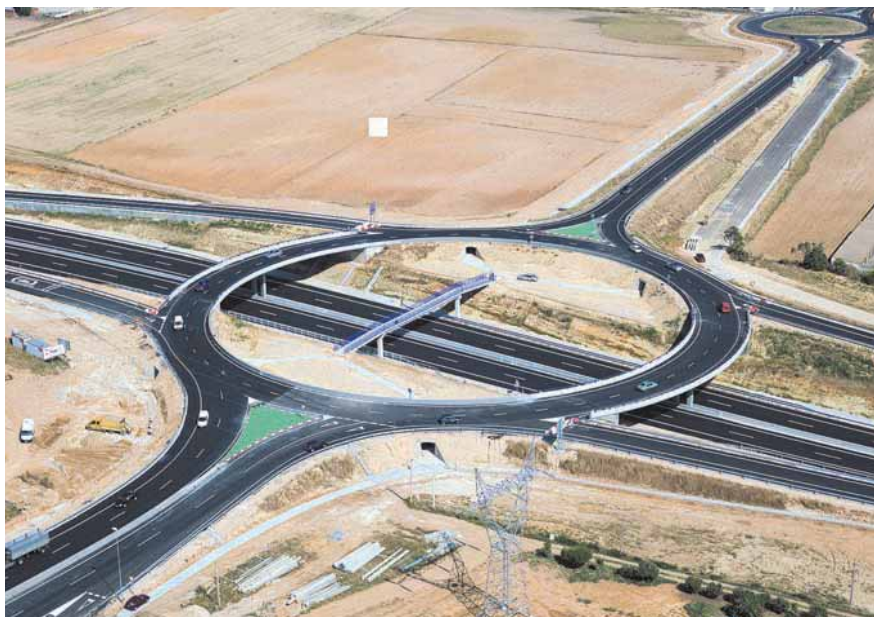
Reposición N-630 (estructuras E-4 y E-5).
