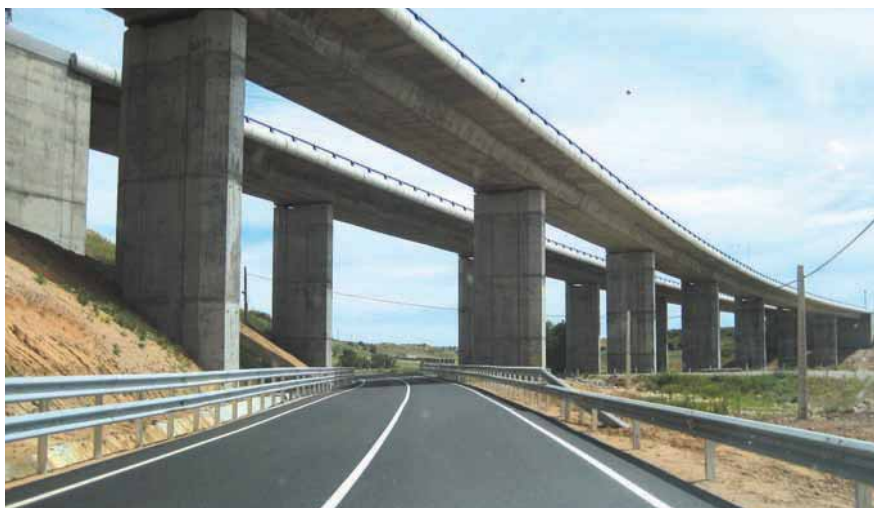
Detalle de los viaductos (estructura E-7).
