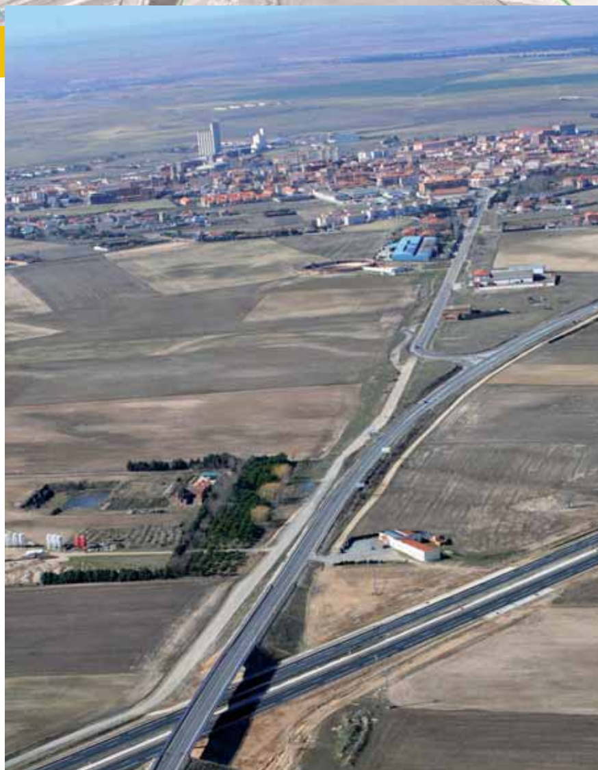
El nuevo tramo atraviesa los términos municipales de Cantaracillo, Peñaranda de Bracamonte, Aldeaseca de la Frontera y Villar de Gallimazo.
