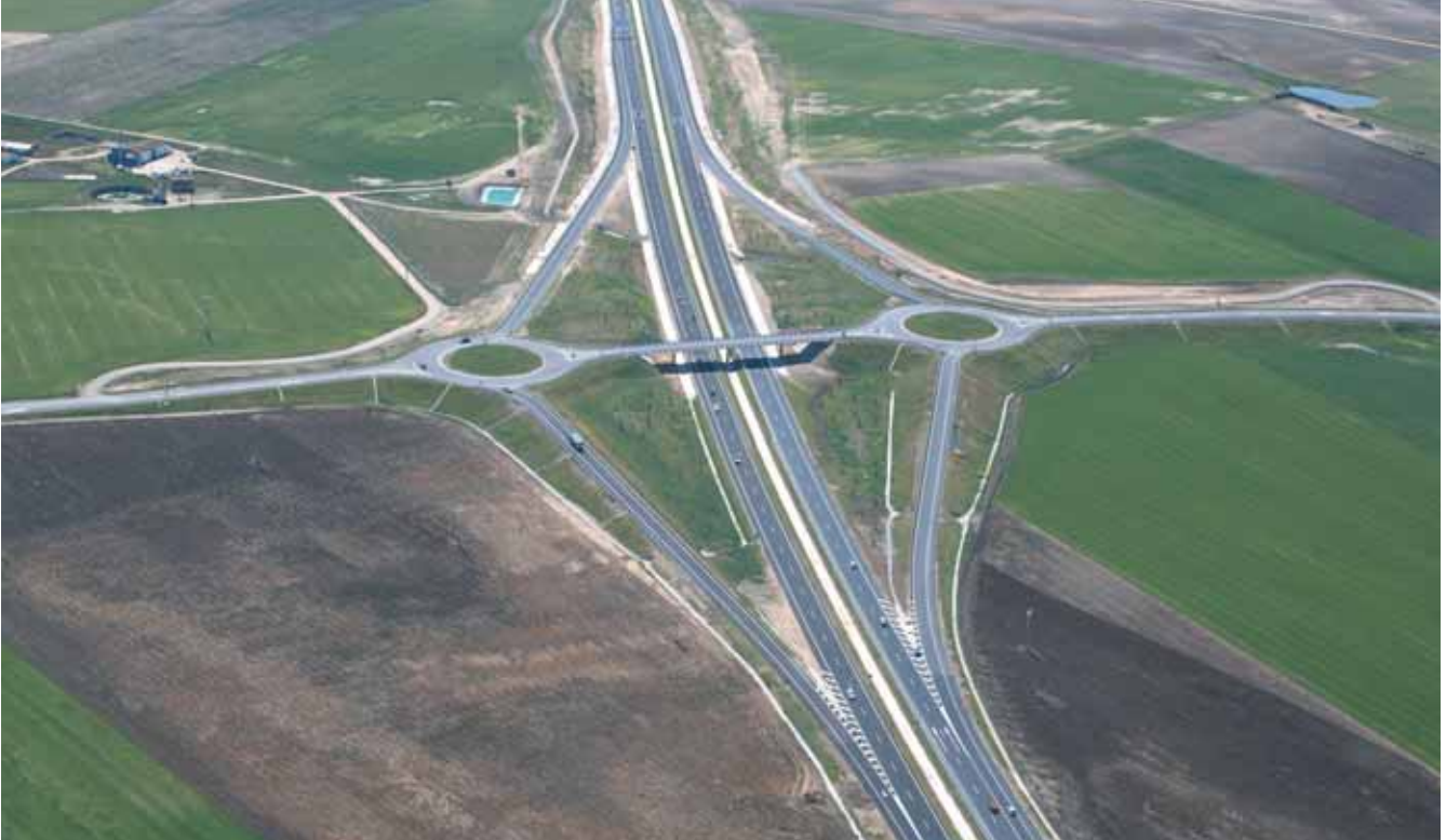
A lo largo del trazado se han ejecutado dos enlaces de tipo diamante con pesas y 4 ramales.
