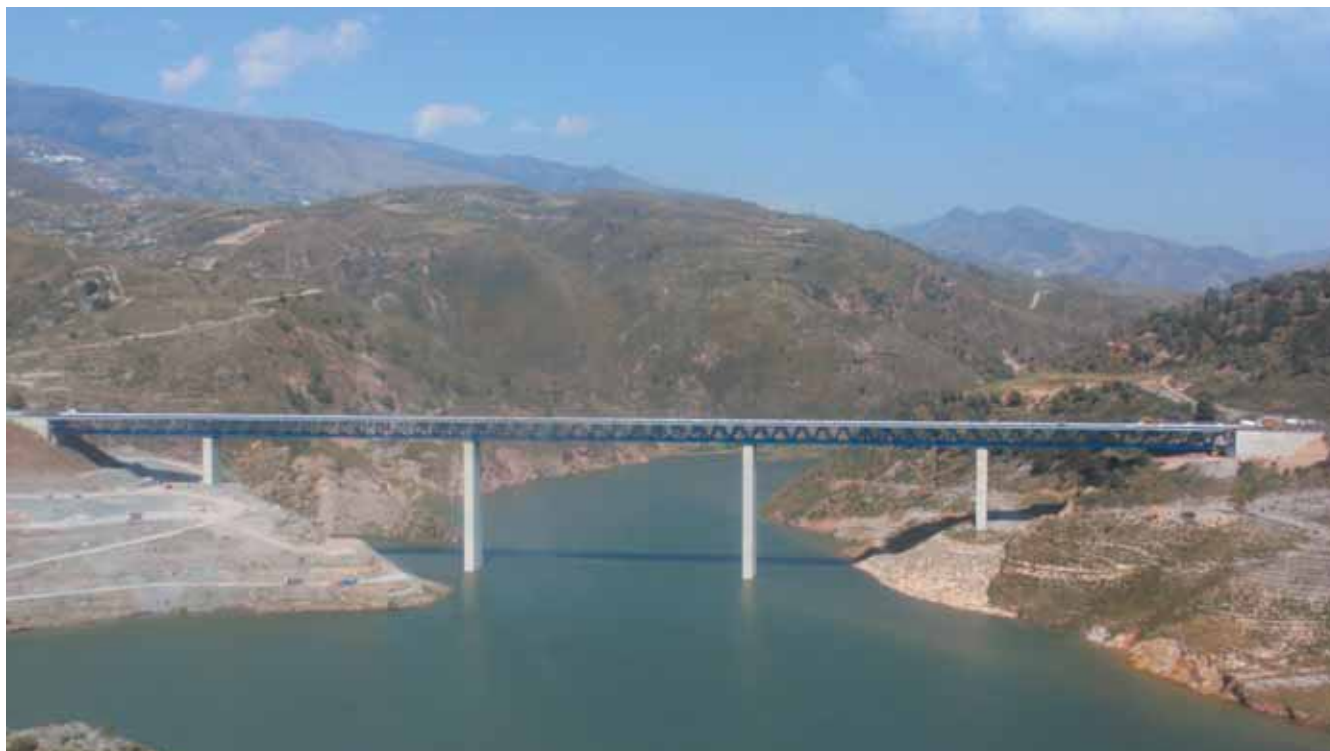
El viaducto del embalse de Rules está formado por un tablero único de 24 m de anchura y 585 m de longitud.
