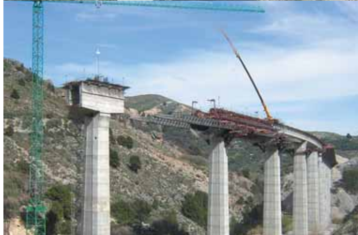
Autocimbra. Viaducto Ízbor.
