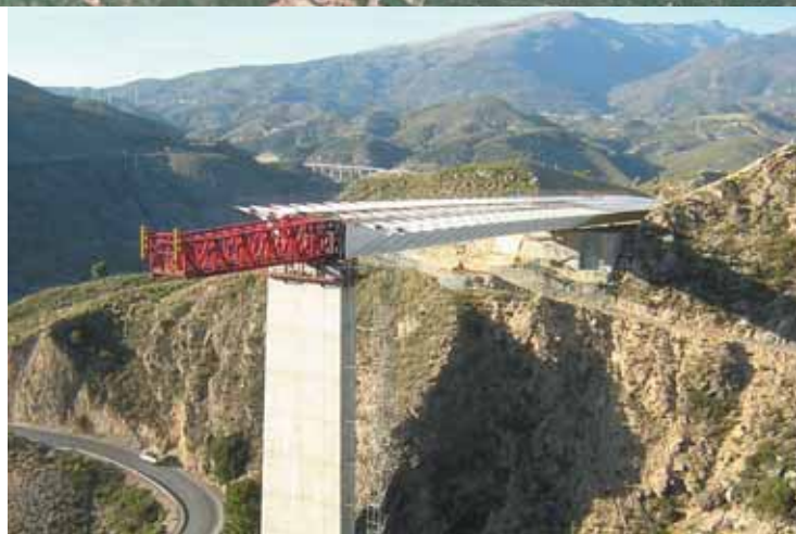
Lanzamiento del viaducto Vicario.
