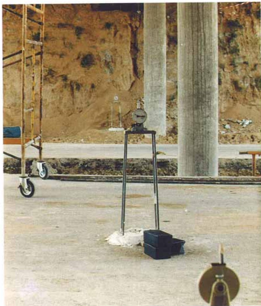
Prueba de carga de un puente. Posición de flexímetros.
