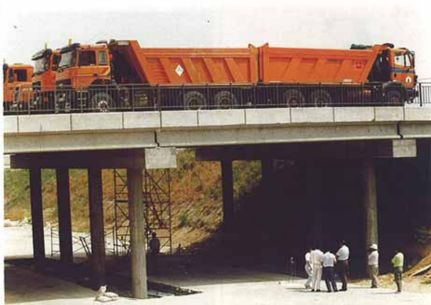
Prueba de carga de un vano de puentes. Tren de cargas.
