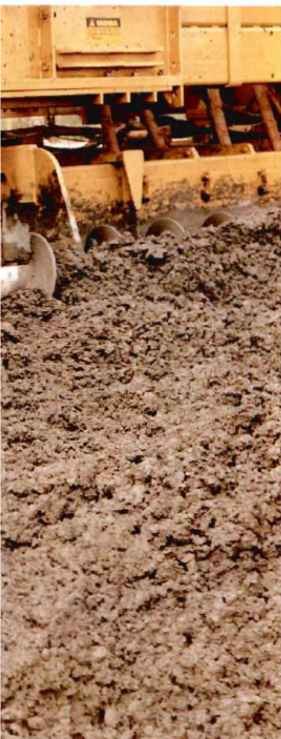
igón para pavimentos (Cono de Abrams 2 cm aproximadamente).
