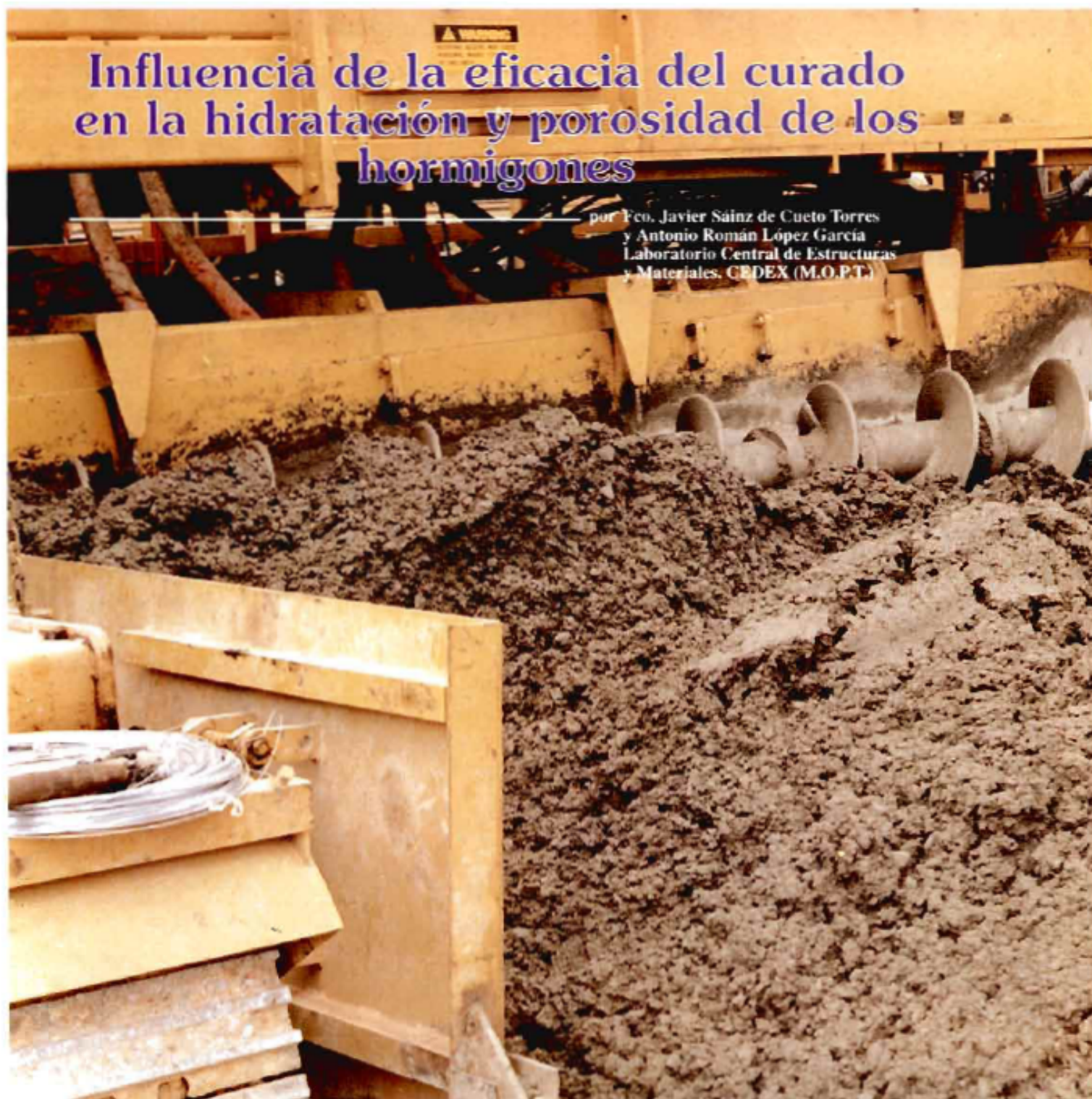
Foto 1. Consistencia del hormigón
