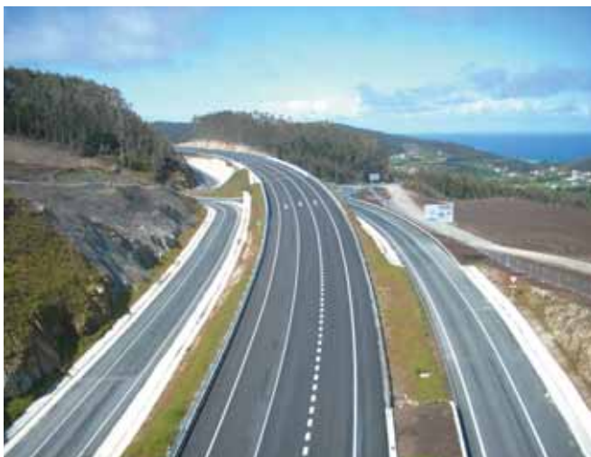
El tramo se ha diseñado con características geométricas de una vía rápida, con carril adicional en las zonas de mayores pendientes.
