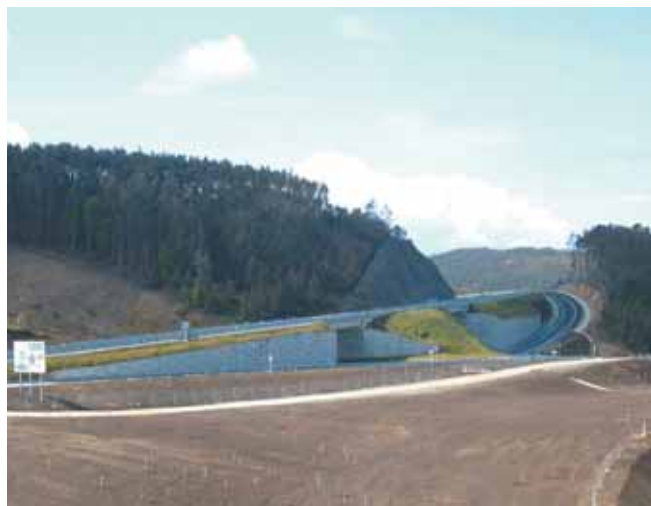
El tramo se ha diseñado con características geométricas de una vía rápida, con carril adicional en las zonas de mayores pendientes.
