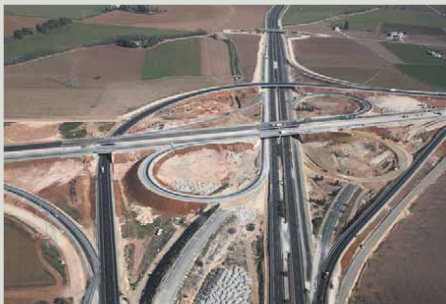
Se ha construido un nuevo enlace que comunica la autovía con la N-331, y se ha remodelado el existente que comunica con la actual A-45.
