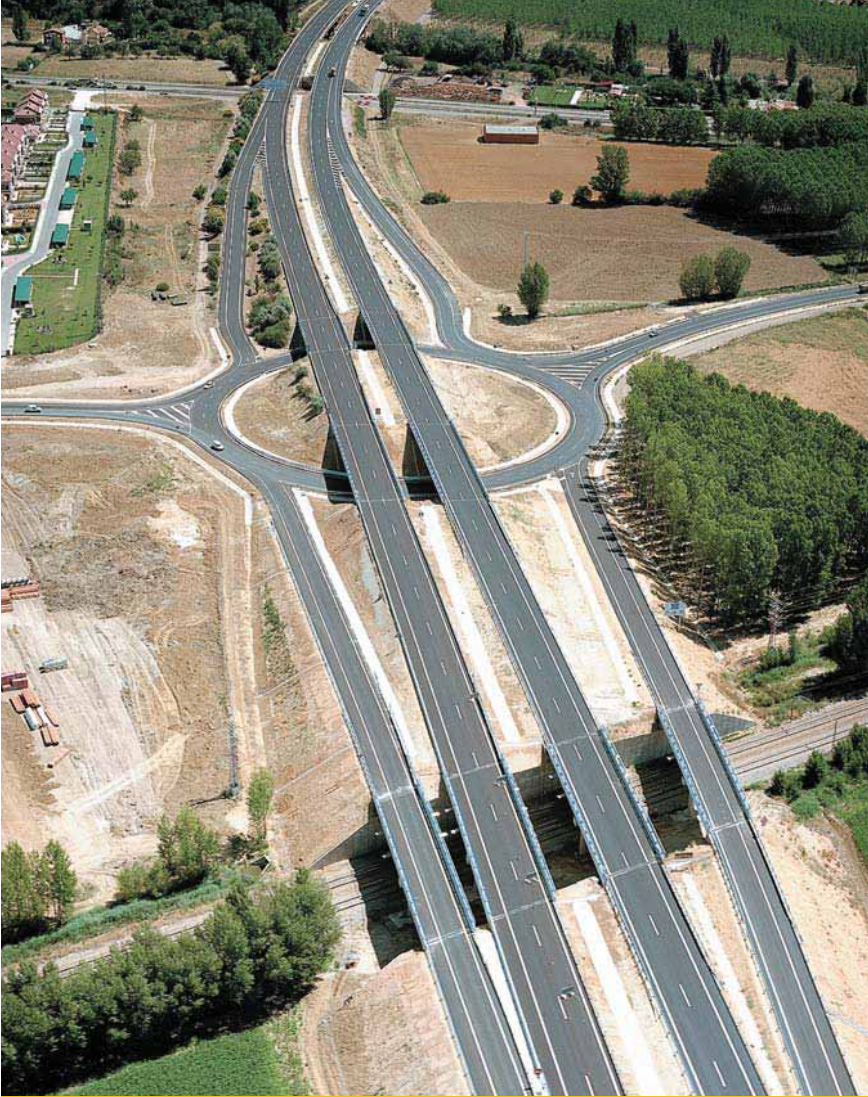
A lo largo del trayecto se han dispuesto dos enlaces: uno de tipo diamante con glorietas y otro de tipo glorieta con patas.
