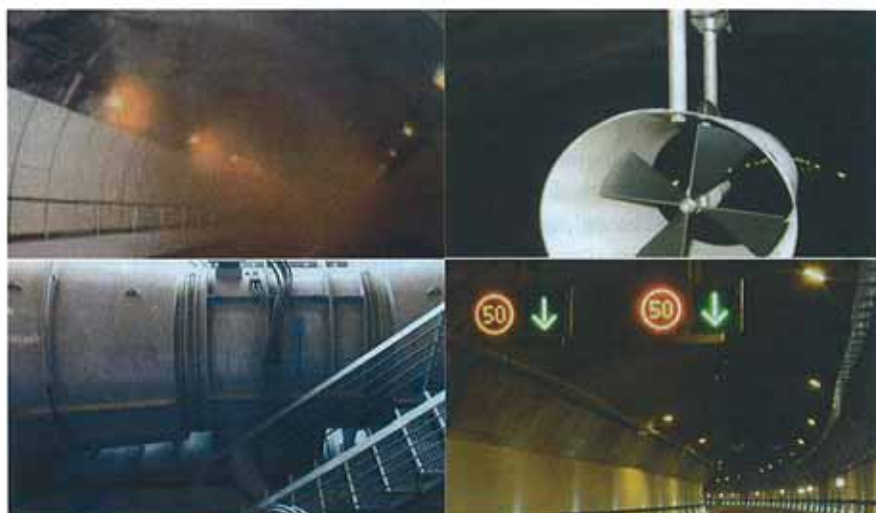
Las instalaciones y el equipamiento para la seguridad fueron temas seguidos con gran interés por parte de los asistentes. En las fotos, de izquierda a derecha y de arriba a abajo: rociadores en túnel, anemómetro de hélice, ventiladores y alumbrado de guía.
