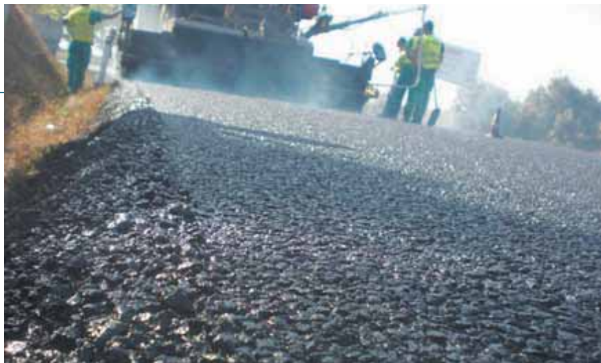
Refuerzo de altas prestaciones. M-501 y M-855. Comunidad de Madrid. Contratista: Ecoasfalt. BBTM 11 M B con BMAVC-3.
