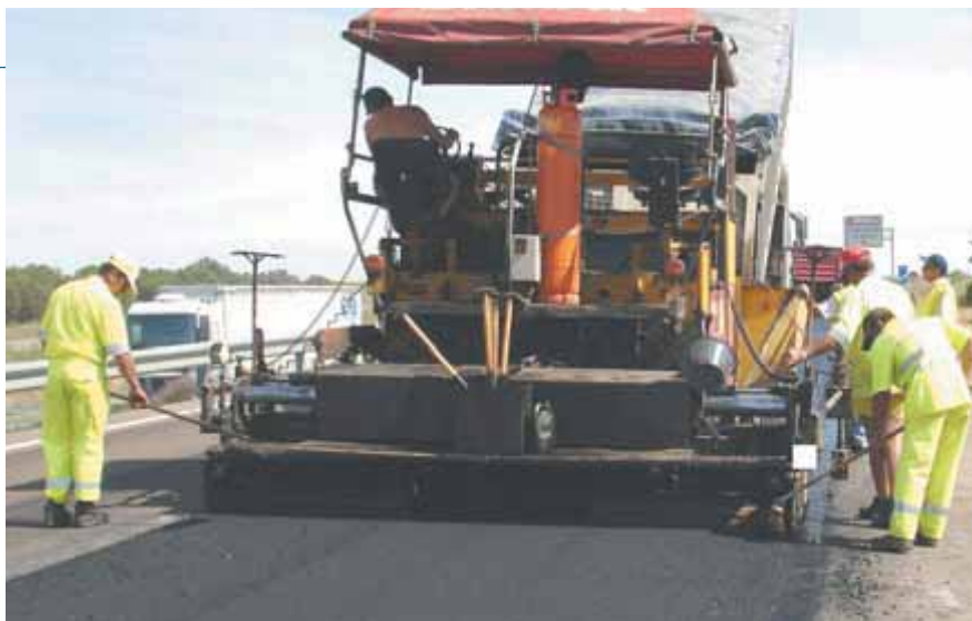
Fresado y reposición A-6. Valladolid. Ministerio de Fomento. Hergonsa. AC 22 S con BMC-2.
