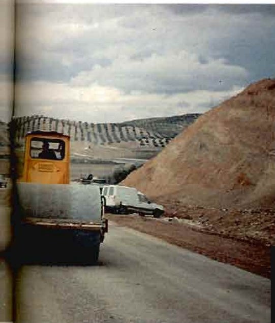
Compactación del hormigón con rodillo.
