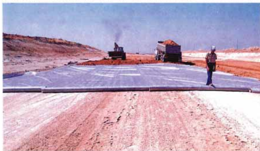
Empleo de lámina de geotextiles
