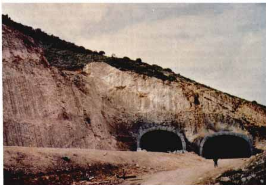
Excavación realizada para dos túneles de paso
