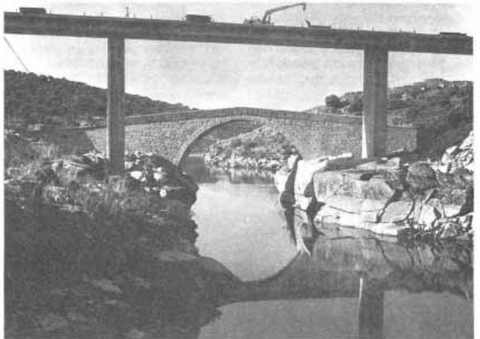
El puente romano «Pontón de Guijo». Delante, el nuevo puente.
