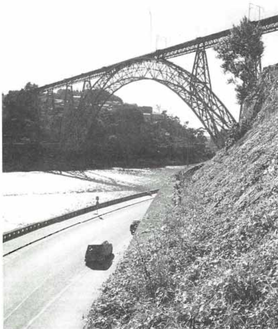
Puente sobre el Duero en Portugal.
