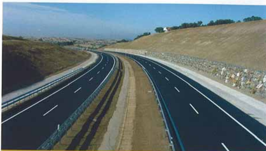
El tramo L.P. Cáceres-Aljucén se ha diseñado con un radio mínimo en planta de 1250 m y una pendiente del 3,9%.
