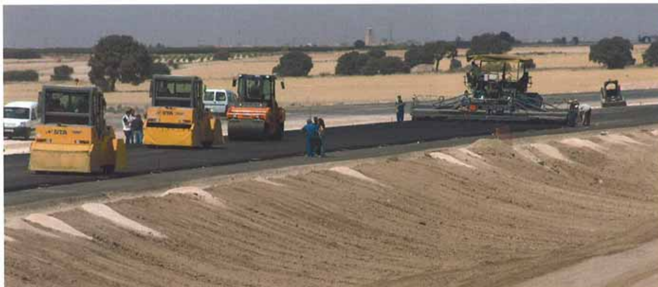
Extensión de mezclas bituminosas a ancho completo.
