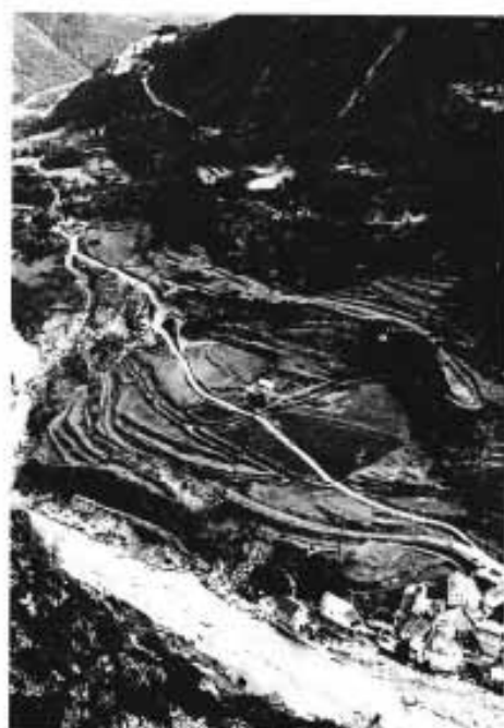
Figura 1.—ASPECTO GENERAL DEL DESLIZAMIENTO.
