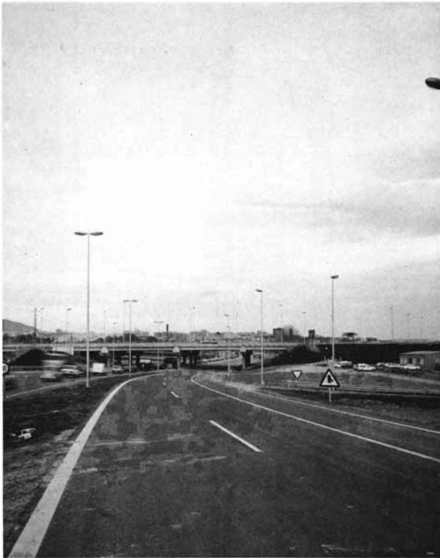
de 1,00 m. Cuatro vanos con 7 vigas de 25,50 m. en los dos extremos. El tablero se apoya sobre 3 pilas y 2 cargaderos sobre terraplán. Longitud del tablero, 81 m.
