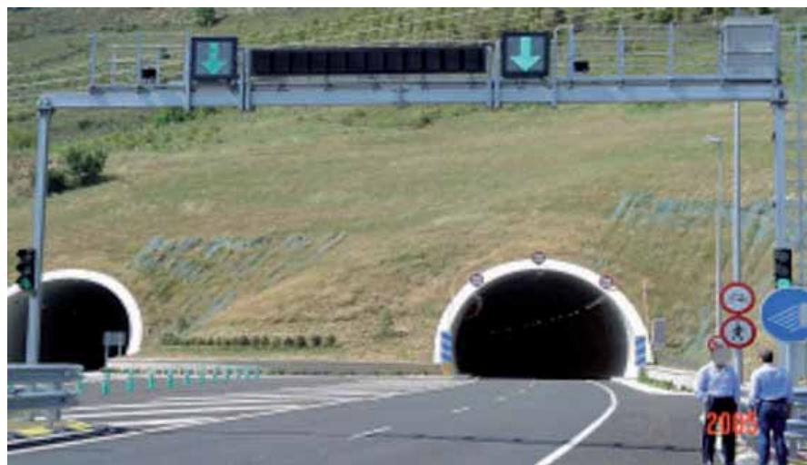
En ambos casos el PMV dispondrá siempre de integración de una zona gráfica, mediante color directo ámbar y no por mediante mezcla de los led's que configuran un píxel.
