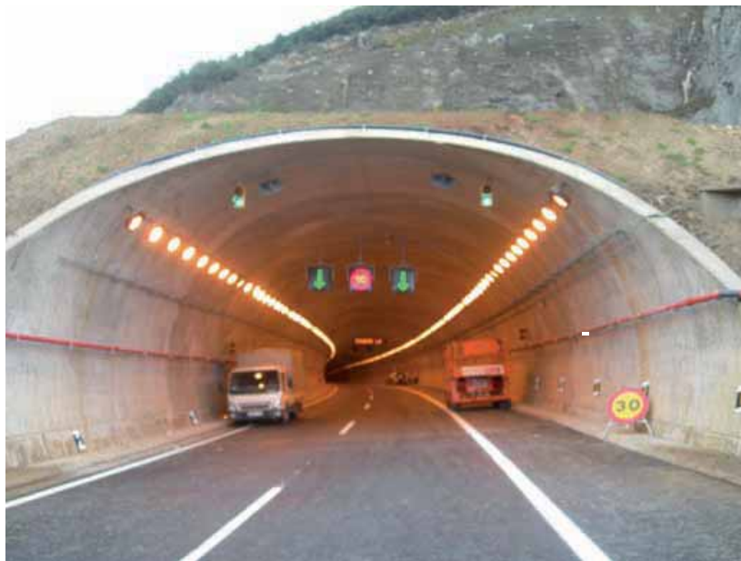
Foto1: Sección de túnel con los dos anchos de arcén: derecha 2m, izquierda 1m.
