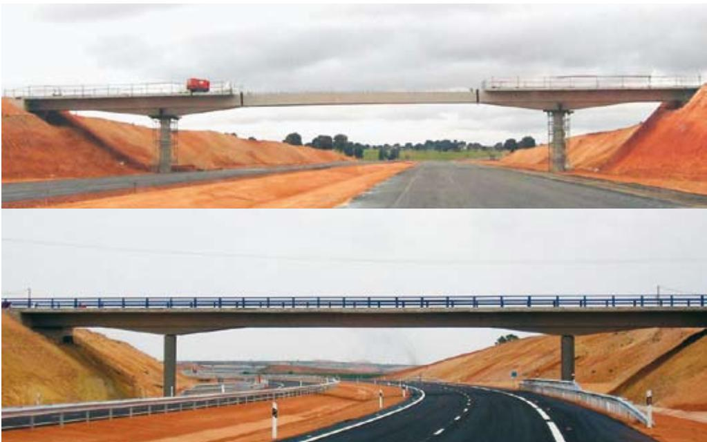
gón pretensado con esbelteces comprendidas entre 1/22 y 1/30 en el caso de canto constante. Si se trata de tableros de canto variable se utilizan esbelteces entre 1/35 y 1/45 en centro de vano, y entre 1/18 y 1/22 sobre apoyos.
