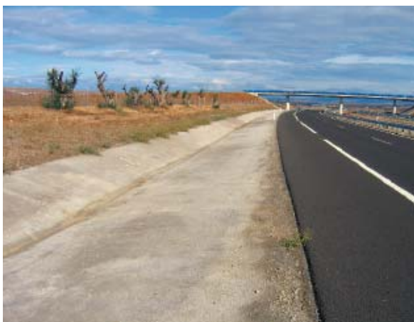
Foto 4. Hormigonado de cunetas laterales y bermas.
