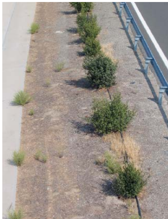
Foto 2. Sistema de riego en medianas.
