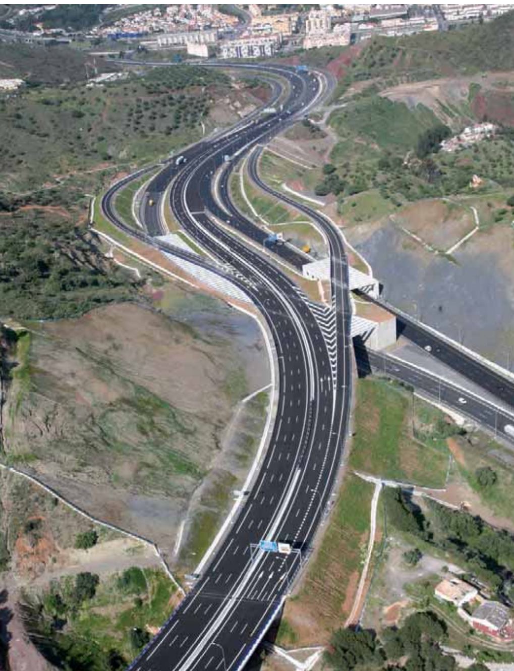
Estructura tipo pérgola en el enlace con la A7.
