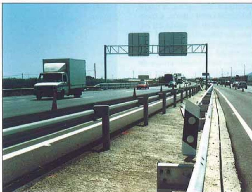
Nueva mediana con caz de recogida de aguas.
