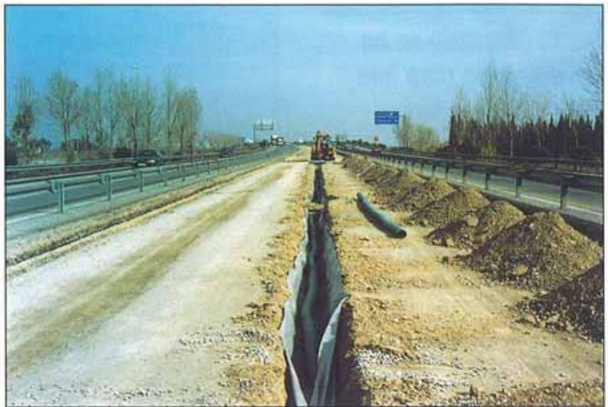
Colocación de un tubo dren en la mediana.
