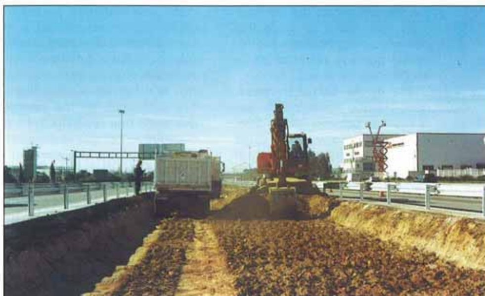
Obras de excavación de la caja.
