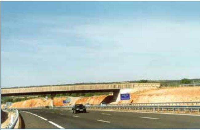
Figura 10. Paso de fauna específico en la N III.
