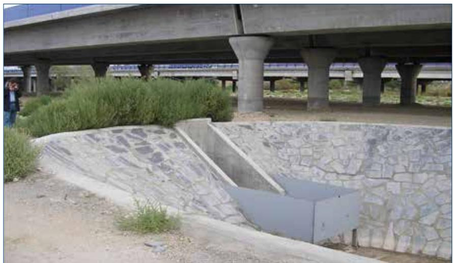
Figura 8. Balsa bajo la R4 para retener la contaminación de las aguas del drenaje.
