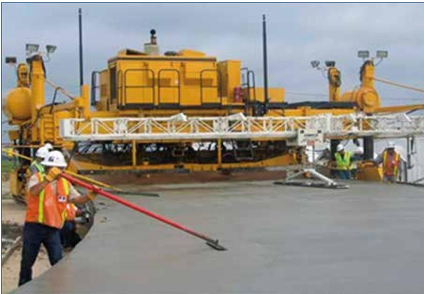
Figura 2. Equipo de extendido de pavimento de hormigón.
