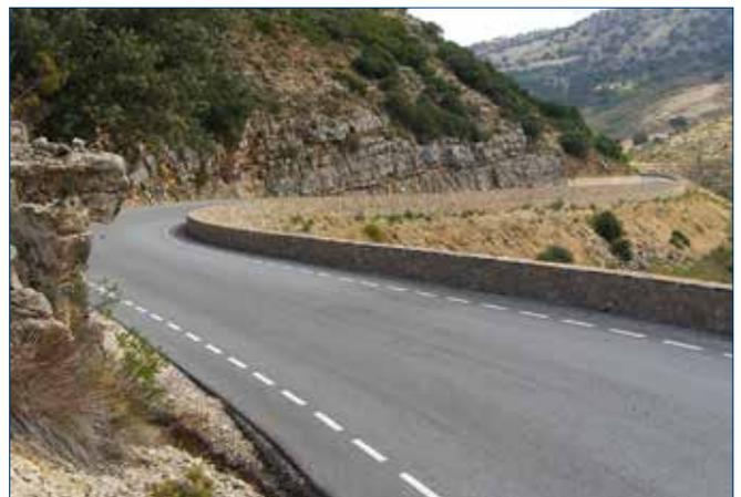
Carretera A-369 en el valle del Genal (Málaga). El acondicionamiento realizado ha respetado aquí el talud rocoso, que aporta una textura de calidad. Se ha ampliado la plataforma mediante un muro de mampostería que sirve también de pretil. La zona ha sido revegetada con posterioridad a esta toma.
