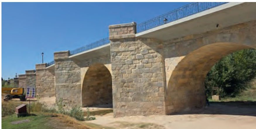
Figura 11. Vista de los alzados una vez terminadas las operaciones de consolidación y limpieza
