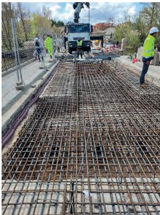
Figura 9. Colocación de la ferralla en la losa micropilotada de los dos vanos nuevos
