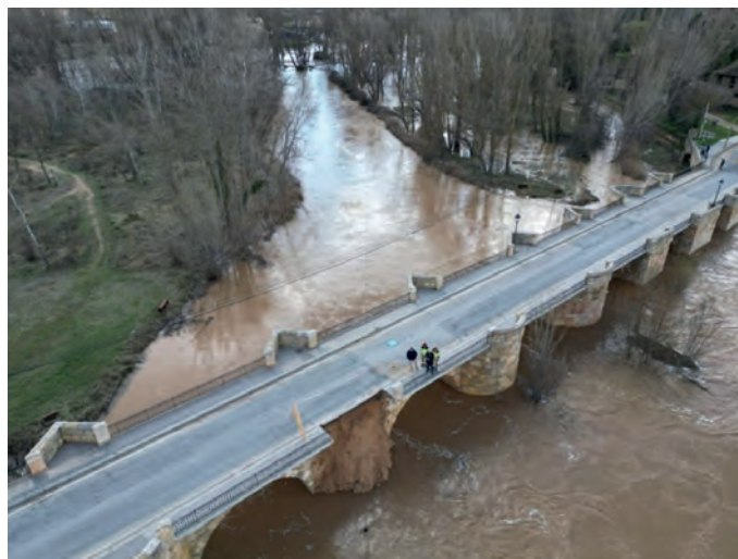
Figura 7. Vista aérea del colapso del tajamar aguas abajo de la pila 10.
