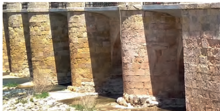
Figura 6. Vista de la obra terminada en 2017. Se puede ver la solera ejecutada y su rastrillo de escollera y se señala el tajamar de la pila 10.
