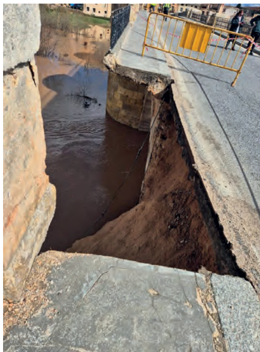
Figura 8. Vista parte superior del colapso del tajamar aguas abajo de la pila 10
